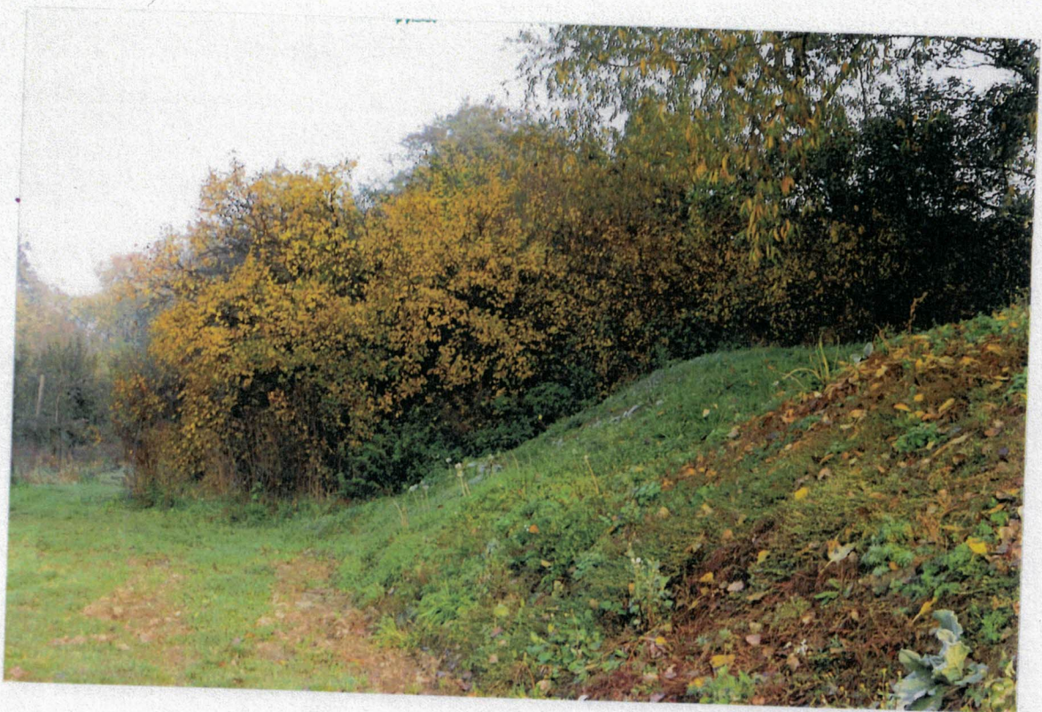
Fot. 8. Krzewy rosnące na wale lewym w rejonie km 4+000. (PVI)
