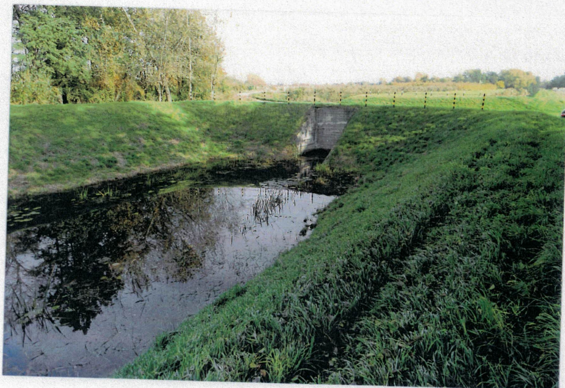
Fot. 2. Przepust pod drogą Sobienie – Wysoczyn. Na lewej grobli przekrój geotechniczny PIII.
