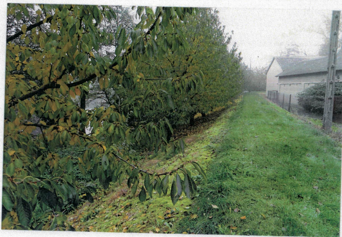
Fot. 10. Wał prawy PVIII, km 2+750. Szpaler drzew na skarpie odwodnej wału.
