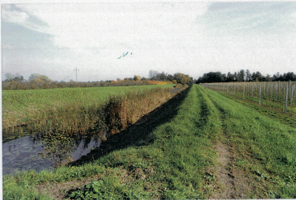
Fot. 4. Odcinek ogroblowanego Kanału od drogi Sobienie – Wysoczyn do J. Piwonińskiego.
